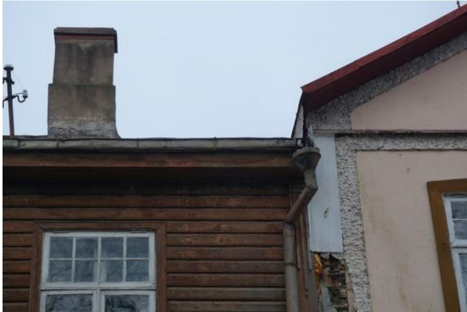
Foto 22. Katariina allee 4b korsten [18]
