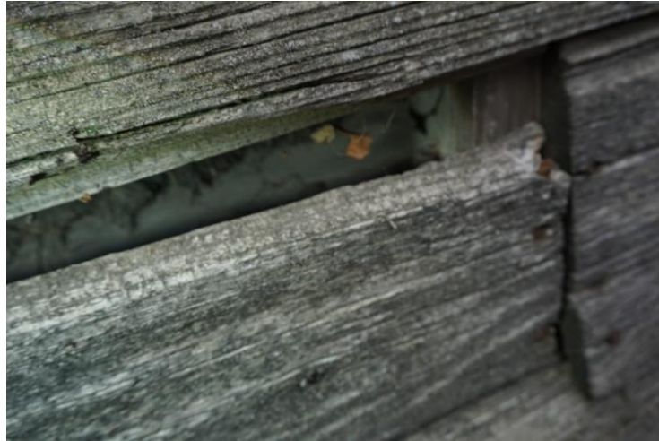
Foto 6. F. R. Kreutzwaldi tn 25a sepanaeltega kinnitatud algupärane laudis [18]
