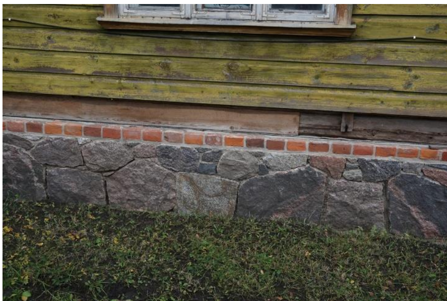
Foto 28. Katariina allée 9 uutest kividest vundament [18]
