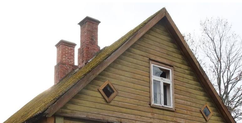
Foto 27. Katariina allee 9 säilitamisele kuuluvad korstnad ning akende piirdeliistud [18]
