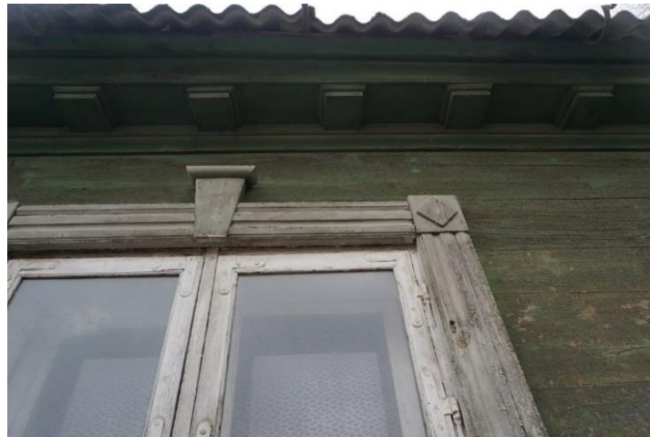
Foto 4. F. R. Kreutzwaldi tn 25a metallmanustega aknad ja akende piirdeliistud [18]
