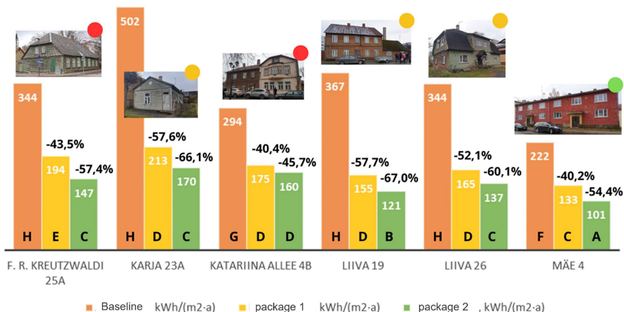
Joonis 1. Hoonete algne olukord ja renoveerimispakettidega saavutatav kokkuhoid energia tarbimiselt. Punane – kõrge kultuuriväärtusega hoone; kollane – mõõduka kultuuriväärtusega hoone; roheline – muinsuskaitsevööndis asuv hoone, millele olulisi muinsuskaitse piiranguid ei kohaldata.
